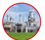
LOCALI AD USO INDUSTRIALE
