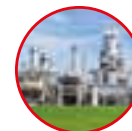
LOCALI AD USO INDUSTRIALE
