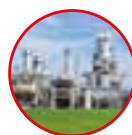
LOCALI AD USO INDUSTRIALE
